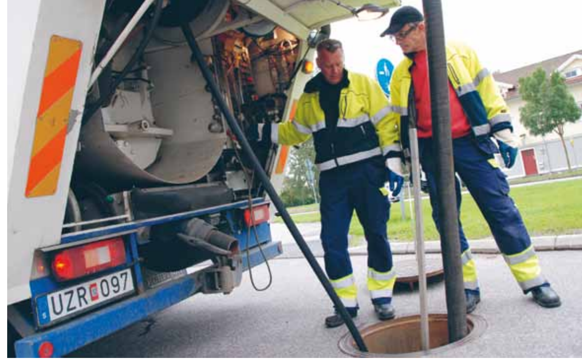
Kommunens VA-avdelning spolrar regelbundet rören för att minska risken för stopp i ledningarna.
