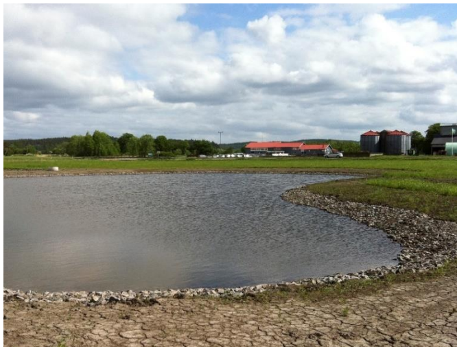
Figur 13 Dagvattendamm med flacka slänter vid Fjärås station, foto: Kungsbacka kommun
