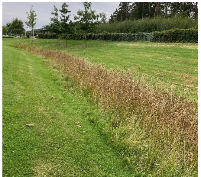
Figur 18. Exempel svackdike och fördröjning i grönyta, Onsalavägen. Foto: Kungsbacka kommun
