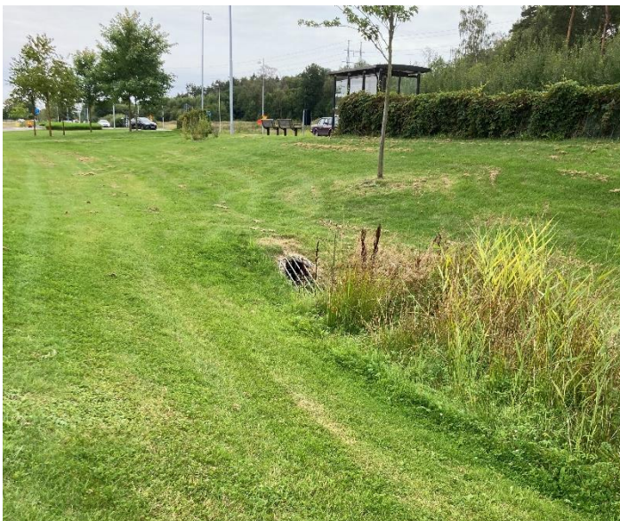
Figur 18. Exempel svackdike och fördröjning i grönyta, Onsalavägen. Foto: Kungsbacka kommun
