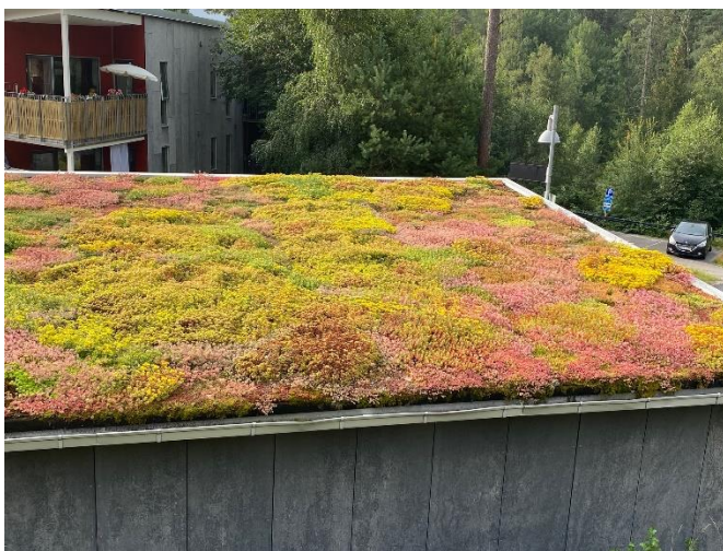
Figur 23 Grönt tak, foto: Sweco
