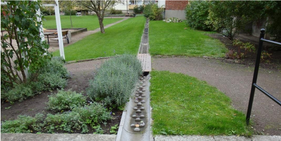
Figur 13. Exempel på ytlig avledning av dagvatten i ränna. © Sweco (2023).
