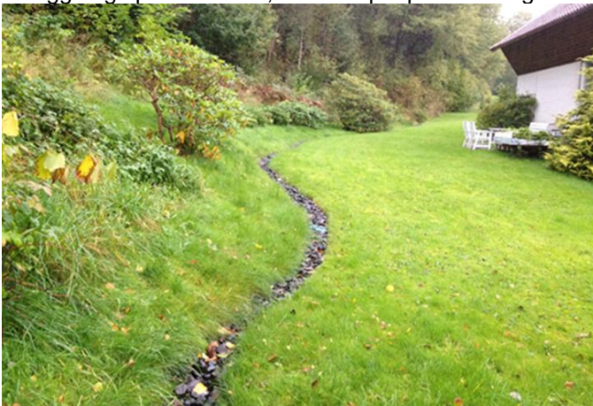
Figur 9. Exempel på avskärmande dike mellan skog och fastighet. © Sweco (2023).
