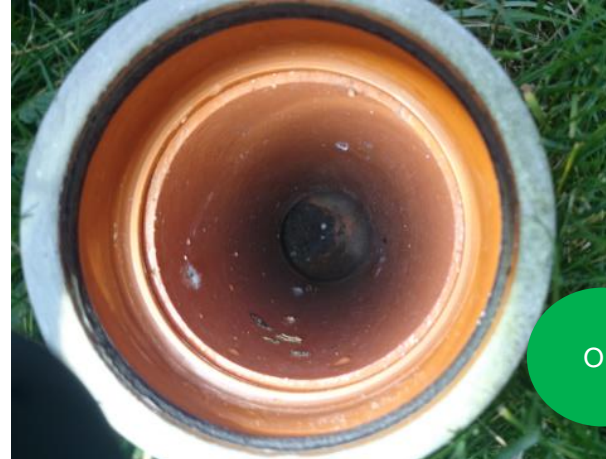
Inget vatten eller slam står i botten av rören.
