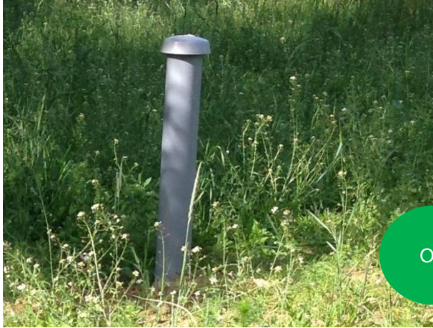
Luftningsrör med ventilerade lock.
