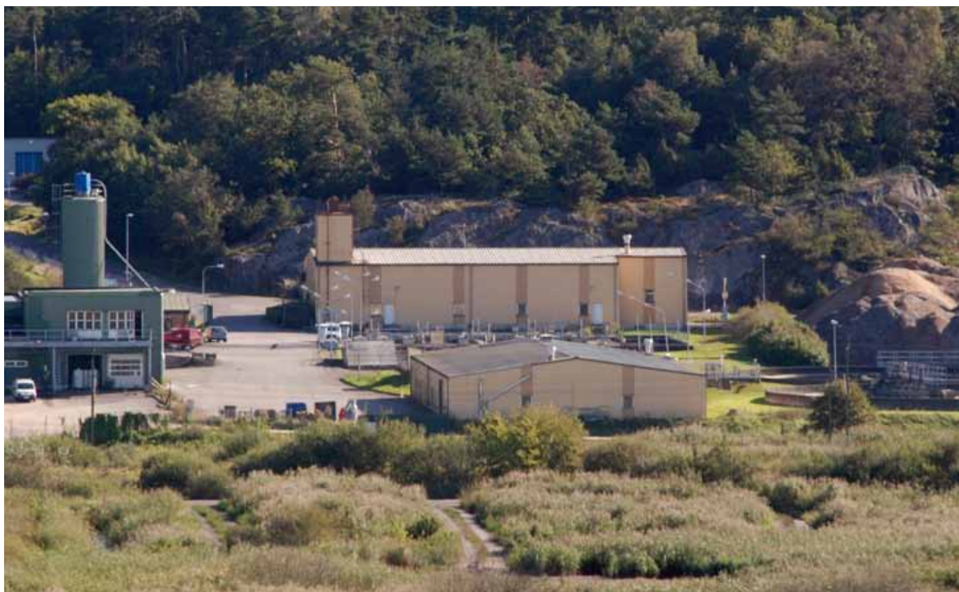
Alla Kungsbackas reningsverk använder biologisk rening, en process som kan störas av föroreningar från bilvårdsanläggningar.
